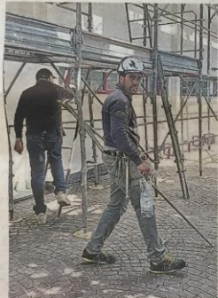
CANTIERI Lavori a una scuola: sono partiti vari interventi a Forte dei Marmi (foto d'archivio)
